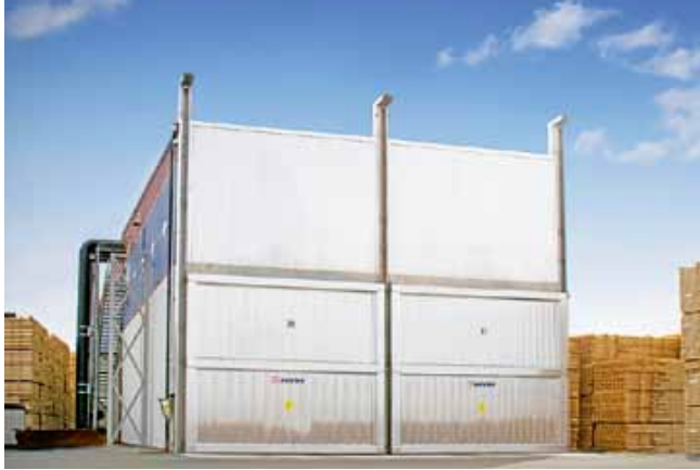
Die Valutec-Trockenkammern sind gut abgedichtete und isolierte Trockner, die, wie ...
